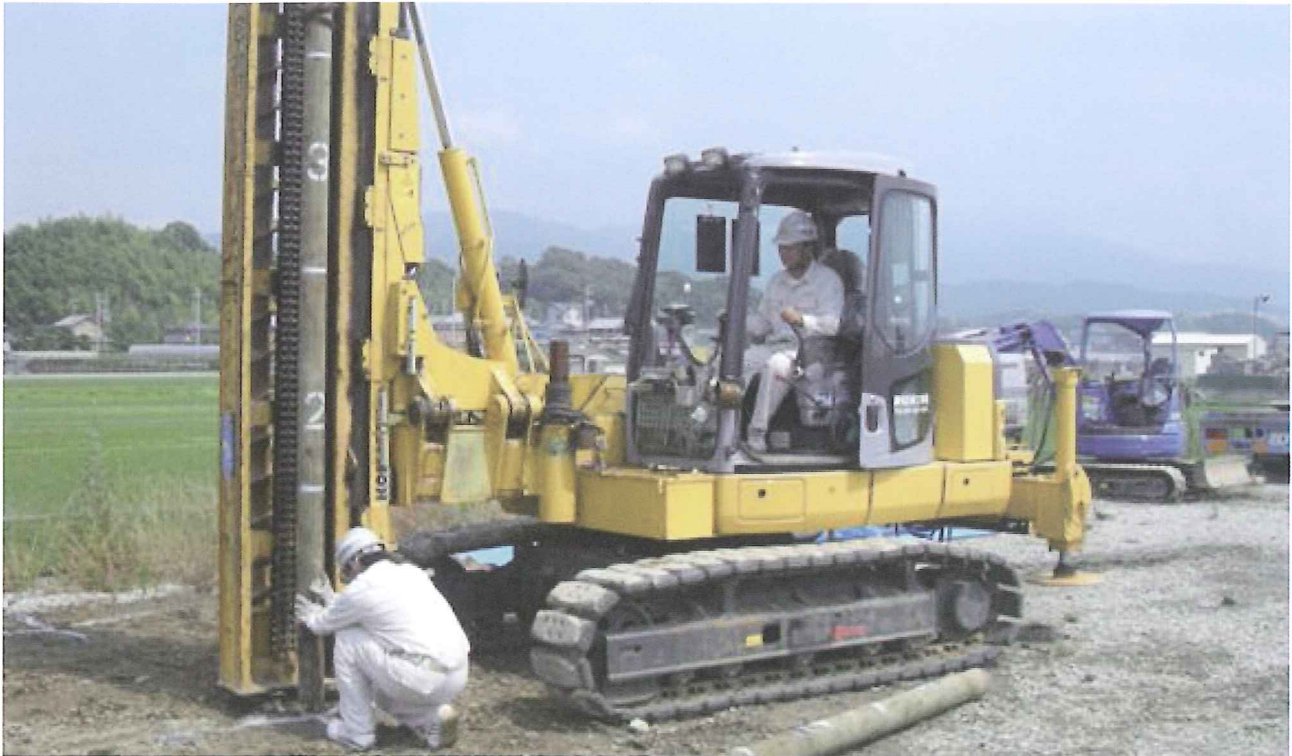
環境パイルの施工状況
