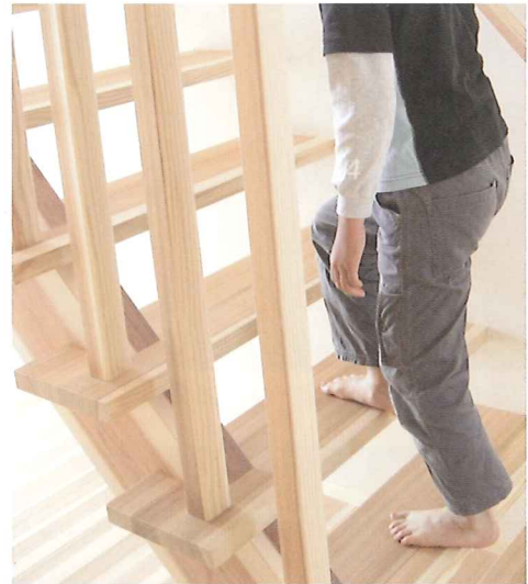
浮造り加工した杉柾目の階段。滑りにくく素足でも快適
