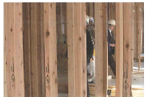
204 国産材杉スタッド施工状況
