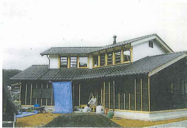
「たじまだら家」施工
