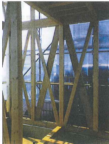
ジャイアントブレース45mm×180mm (45mm×90mm×並行2本筋かい)
