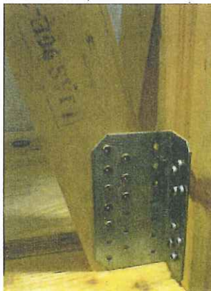
柱、土台の両方を固定する接合金具
