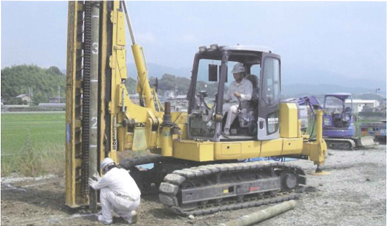
環境パイルの施工状況
