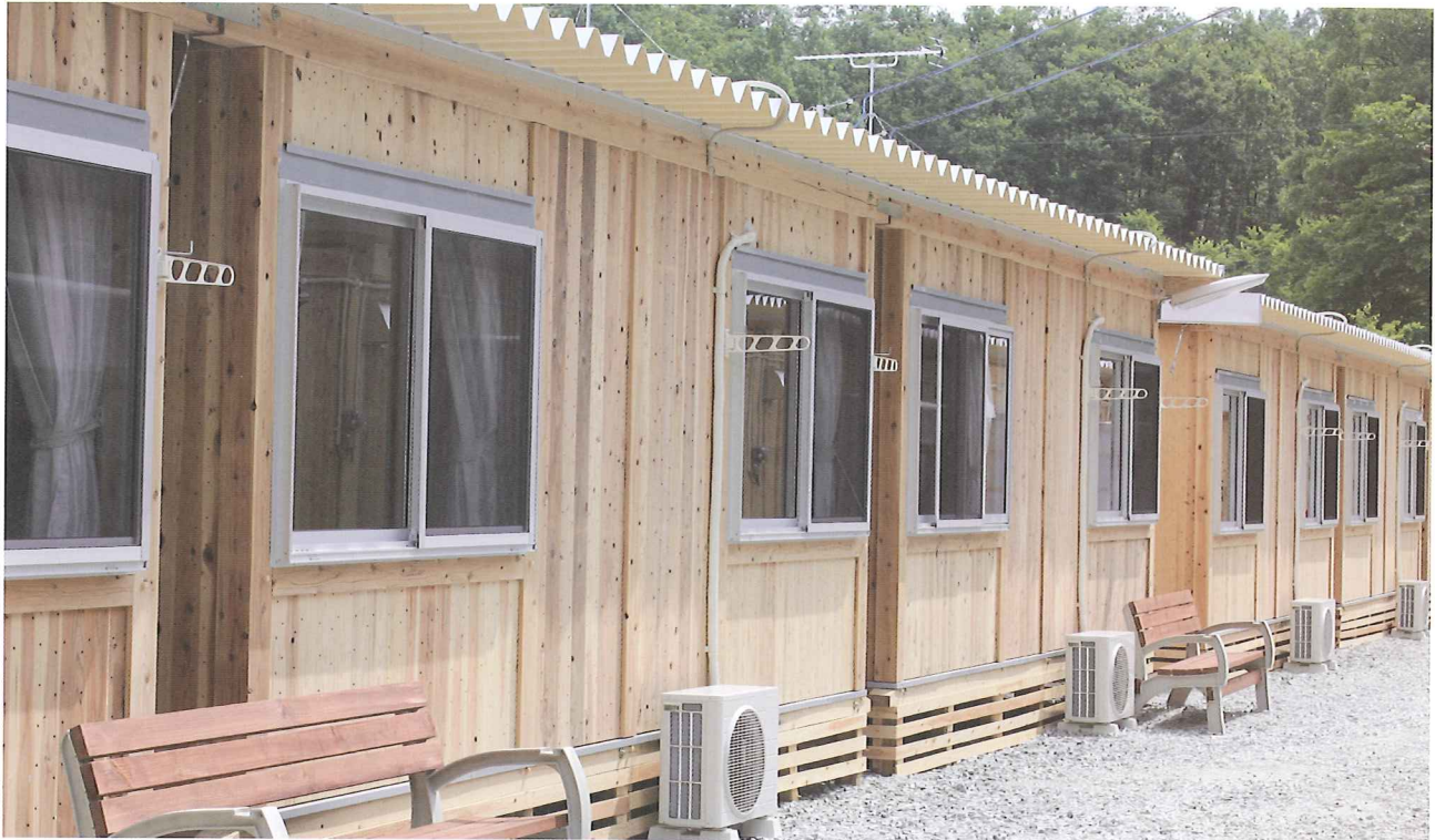
木造軸組板倉工法で会員が建てた応急仮設住宅
