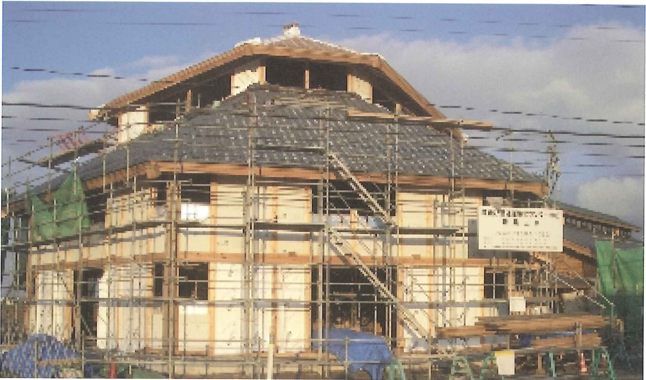
越後杉構造用合板を使用した越後杉流通活性化センター（建築中）
