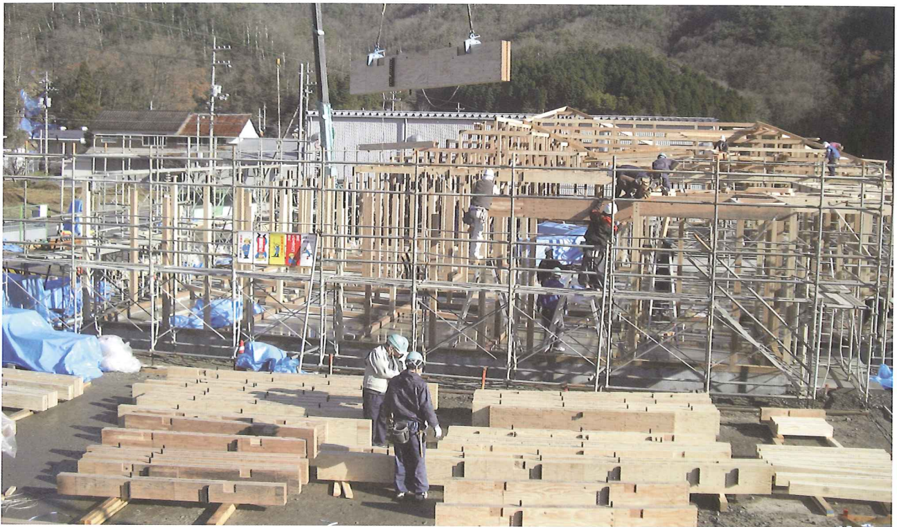
構造材のすべてを杉LVLで建築したグループホーム
