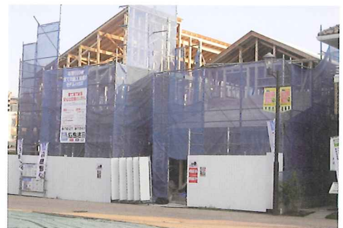
桧LVL構造材のモデル住宅（千葉県）
