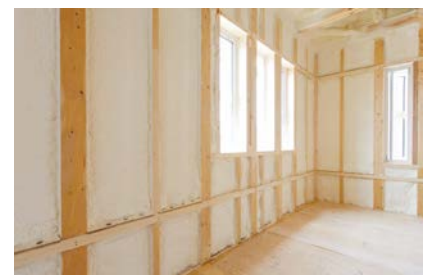
【断熱・気密工事】
