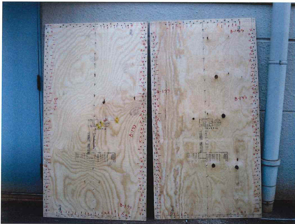
写真 1.27 B-1 解体後 面材(裏)
