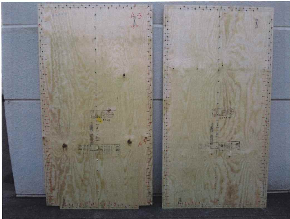
写真 1.18 A-3 解体後 面材(裏)
