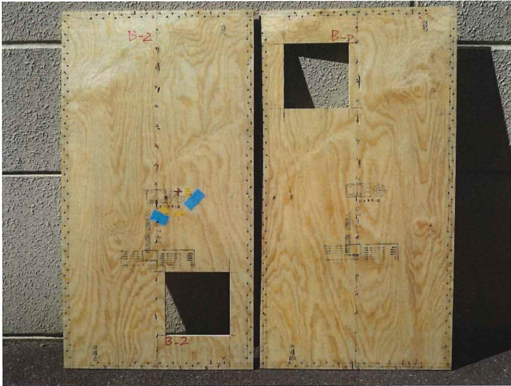
写真 1.33 B-2 解体後 面材(表)
