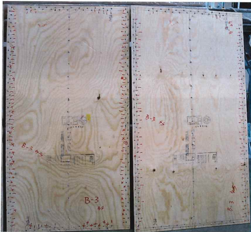
写真 1.41 B-3 解体後 面材(裏)
