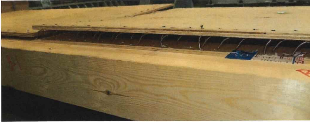
写真 1. 28 B-1 試験終了後 面材の浮き
