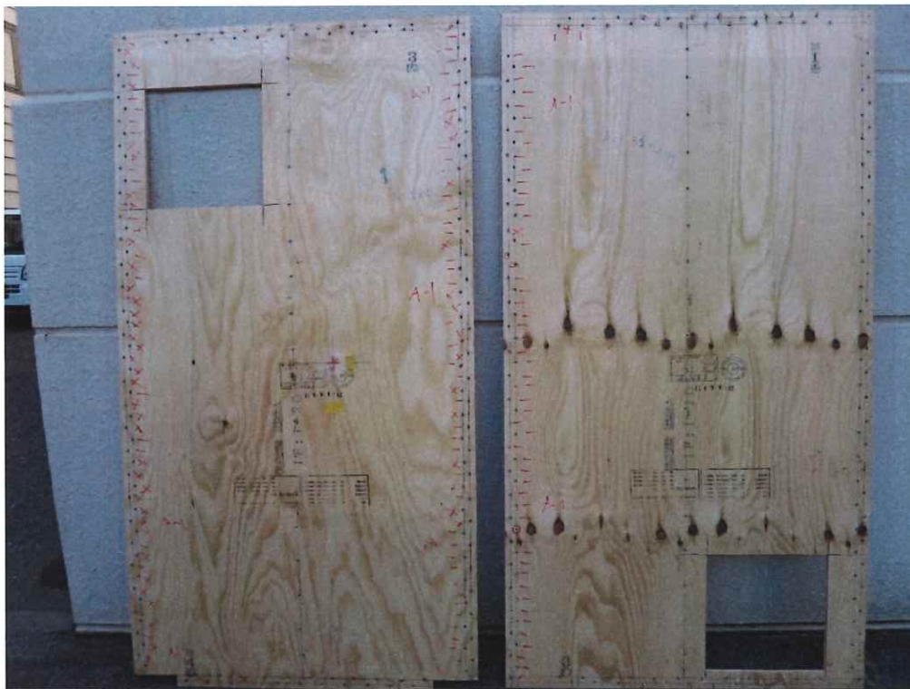
写真 1.4 A-1 解体後 面材(裏)
