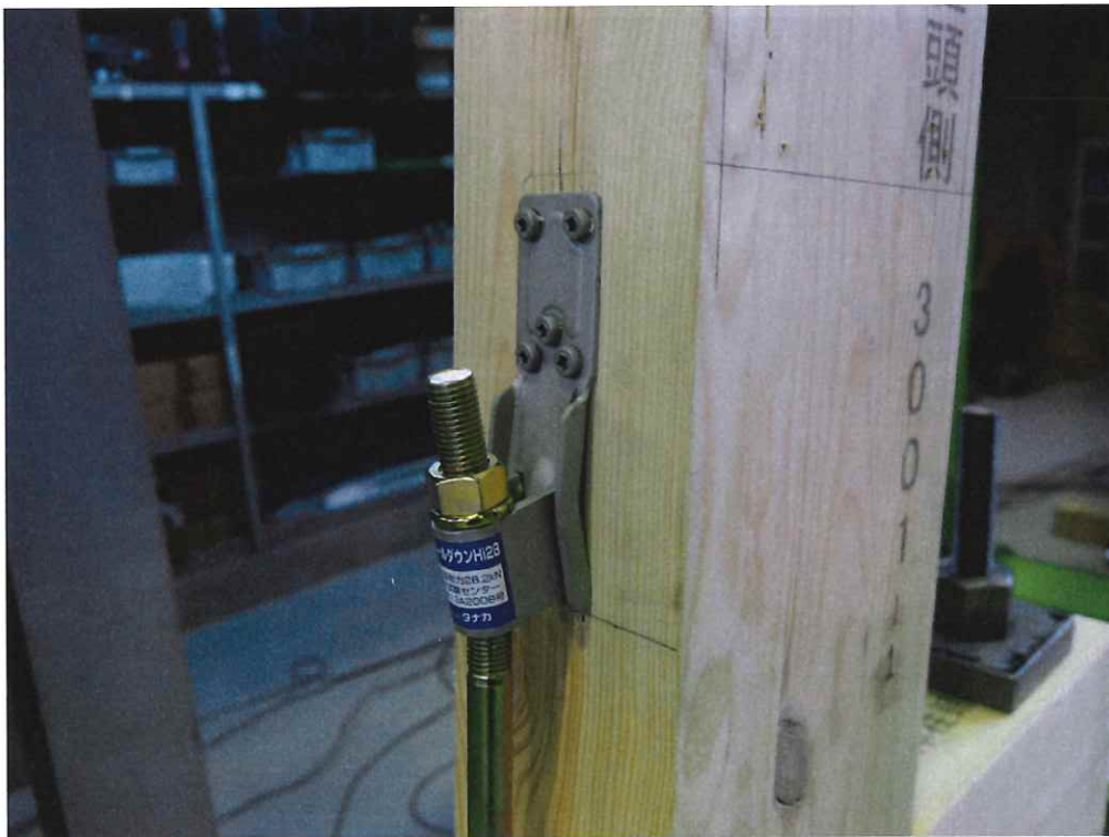
写真 2.26 M-HD-1 試験終了後 ホールドダウン金物の変形
