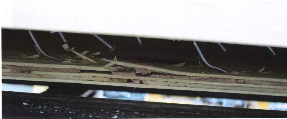
写真 1. 29 B-1 試験終了後 釘の抜け、釘の破断、パンチングアウト
