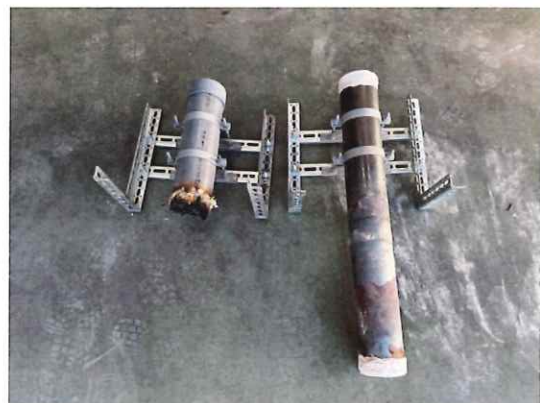
写真 3-4 配管の解体時（仕様 1,2）
