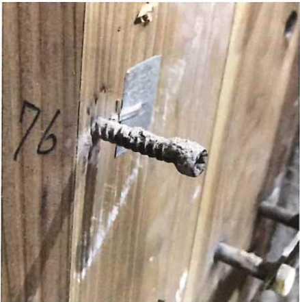
写真 1-41 仕様 26 の解体時 (CLT 表面) (単独 パネリード (PX8-110 ))
