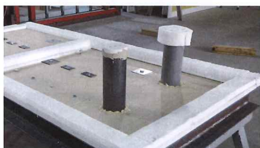
配管の施工状況
