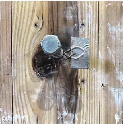
写真 2-39 仕様 18 の解体時 (CLT 表面) (直貼 コーチボルト M16+RW カバー)
