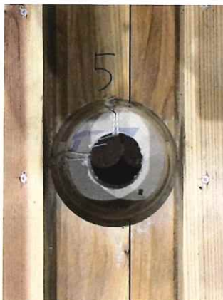
写真 1-17 仕様 5 の解体時 (CLT 躯体) (かぶせタイプ VP 管 50GB-F(V)21mm 厚×2 枚+RW)
