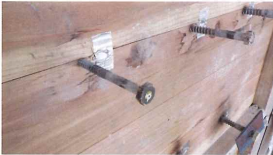
写真 3-33 仕様 14 の解体時 (CLT 表面) (胴縁 コーチボルト M9/L150)
