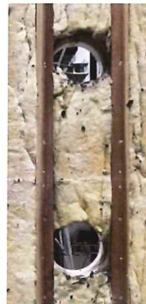
写真 1-16 仕様 7,8 の解体時 (胴縁) (増張タイプ GB-F(V)21mm 厚×2 枚+RW)
