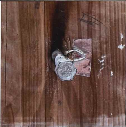
写真 2-25 仕様 11 の解体時 (CLT 表面) (胴縁 コーチボルト M16/L125)
