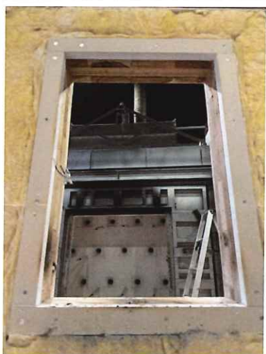
写真 2-1 仕様 1 の解体時（不燃胴縁）
