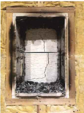
写真 1-5 仕様 3 の解体時（木製胴縁）
