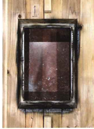
写真 1-2 仕様 1 の解体時（CLT 躯体）
