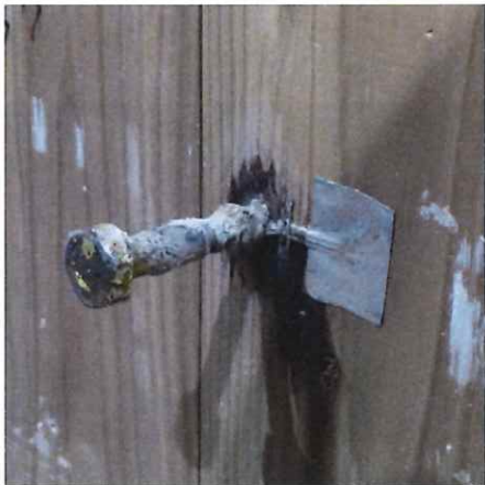
写真 1-35 仕様 8 の解体時 (CLT 表面) (単独 コーチボルト M9,L90)
