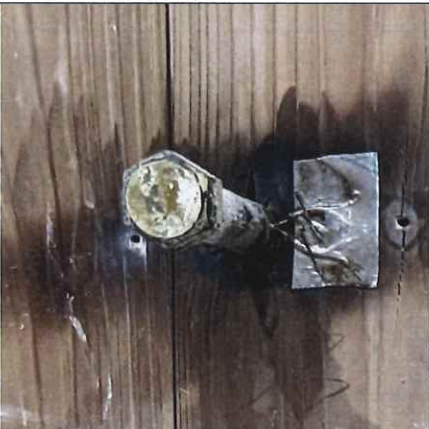
写真 2-45 仕様 21 の解体時 (CLT 表面) (直貼 コーチボルト M16+加熱発泡材カバー)
