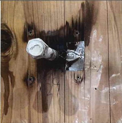
写真 2-37 仕様 17 の解体時 (CLT 表面) (直貼 コーチボルト M16+GW カバー)
