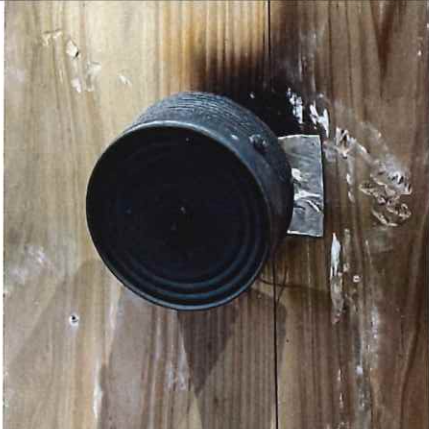
写真 2-47 仕様 22 の解体時 (CLT 表面) (直貼 コーチボルト M16+スチール缶カバー)
