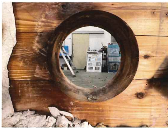
写真 3-6 仕様 2 の解体時（CLT 躯体） （鋼管 100,GB-F(V)21mm 厚×2 枚+RW）
