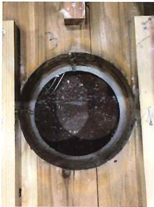
写真 1-13 仕様 3 の解体時 (CLT 躯体) (増張タイプ VP 管 100,GB-F(V)21mm 厚×2 枚+RW)
