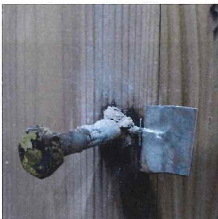
写真 1-37 仕様 9 の解体時 (CLT 表面) (単独 コーチボルト M9,L125)
