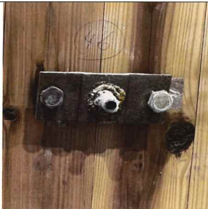
写真 2-71 仕様 34 の解体時 (CLT 表面) (直貼 コーチボルト M16+足改良-2)
