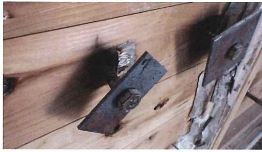
写真 3-19 仕様 7 の解体時 (CLT 表面) (直貼 コーチボルト M16+鉄板)
