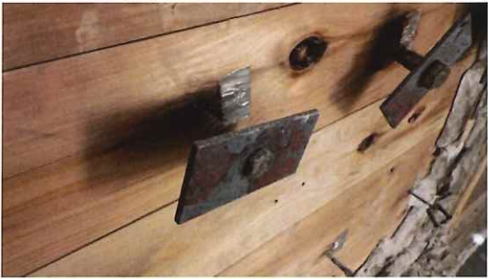
写真 3-17 仕様 6 の解体時 (CLT 表面) (直貼 コーチボルト M9+鉄板)
