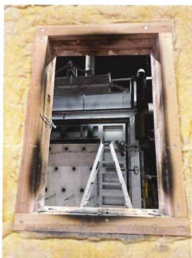
写真 2-3 仕様 2 の解体時 （木製胴縁）
