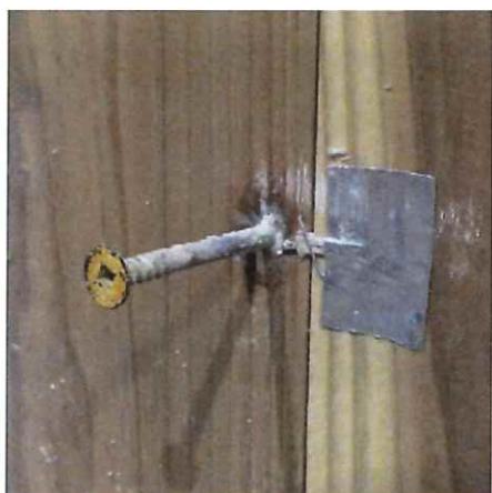
写真 1-31 仕様 6 の解体時 (CLT 表面) (単独 パネリード (P6-120 II+))
