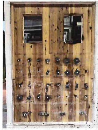
写真 2-84 加熱面・脱炉直後の解体時 (CLT 表面)
