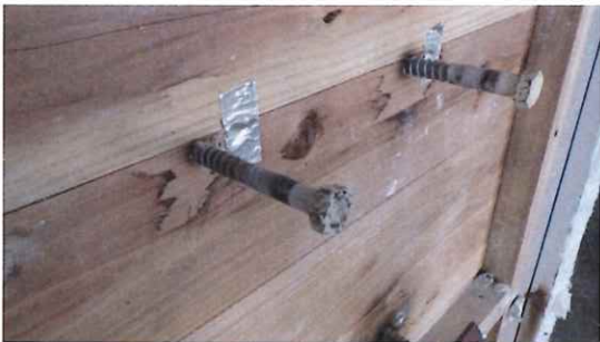
写真 3-35 仕様 15 の解体時 (CLT 表面) (胴縁 コーチボルト M12/L150)
