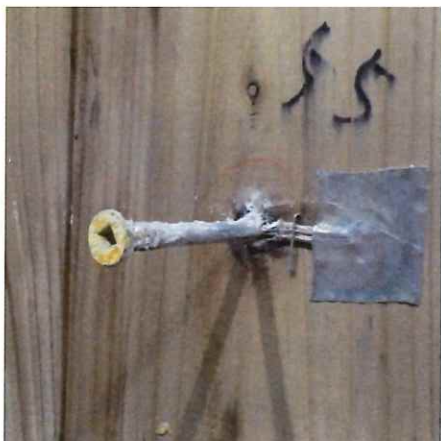
写真 1-29 仕様 5 の解体時 (CLT 表面) (単独 パネリード (P6-90 II+))
