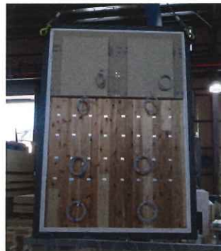
非加熱面側の施工状況 (全景)
