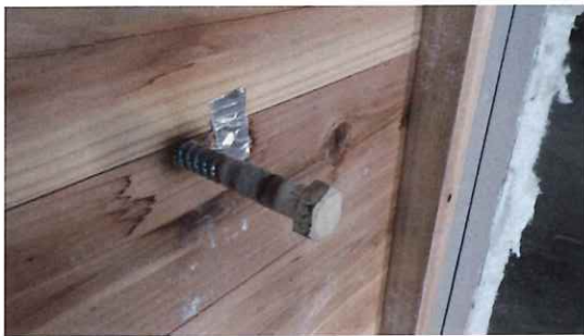
写真 3-37 仕様 16 の解体時 (CLT 表面) (胴縁 コーチボルト M16/L150)
