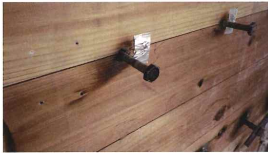
写真 3-7 仕様 1 の解体時 (CLT 表面) (直貼 コーチボルト M9/L90)
