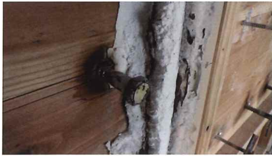
写真 3-13 仕様 4 の解体時 (CLT 表面) (直貼 コーチボルト M16/L100)
