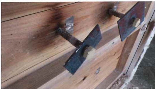
写真 3-41 仕様 18 の解体時 (CLT 表面) (胴縁 コーチボルト M16+鉄板)
