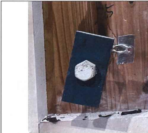
写真 2-29 仕様 13 の解体時 (CLT 表面) (胴縁 コーチボルト M16+鉄板)
