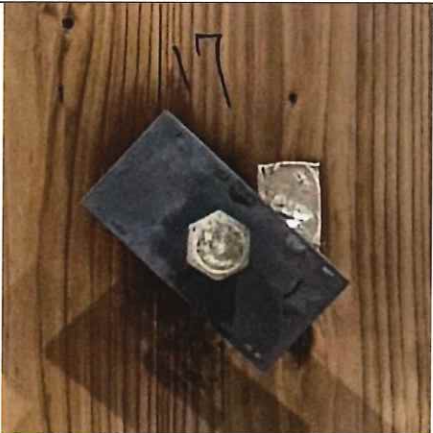
写真 2-13 仕様 5 の解体時 (CLT 表面) (胴縁+断熱材 コーチボルト M16+鉄板)
