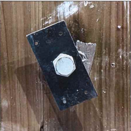
写真 2-57 仕様 27 の解体時 (CLT 表面) (直貼 コーチボルト M16+鉄板+RW カバー)
