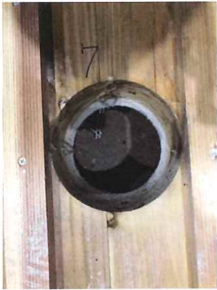
写真 1-19 仕様 7 の解体時 (CLT 躯体) (増張タイプ VP 管 50GB-F(V)21mm 厚×2 枚+RW)
