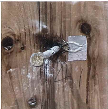
写真 2-61 仕様 29 の解体時 (CLT 表面) (直貼 コーチボルト M9+GBF-(V)12.5)
