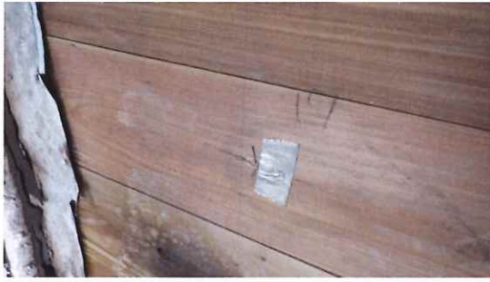
写真 3-31 仕様 13 の解体時 (CLT 表面) (直貼 留め具なし)
