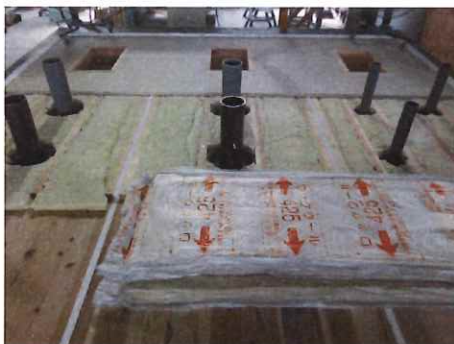
開口小口・設備貫通の施工状況
