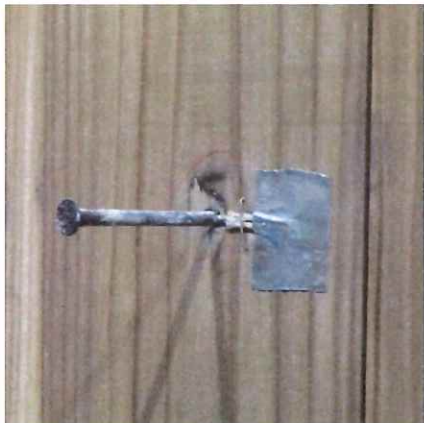
写真 1-23 仕様 2 の解体時（CLT 表面） （単独 N90 くぎ）
