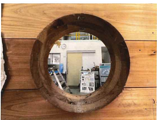
写真 3-5 仕様 1 の解体時（CLT 躯体） （VP 管 100,GB-F(V)21mm 厚×2 枚+RW）
