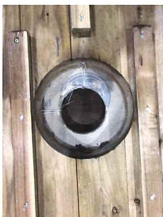
写真 1-11 仕様 1 の解体時（CLT 躯体） （かぶせタイプ VP 管 100,GB-F(V)21mm 厚×2 枚+RW）
