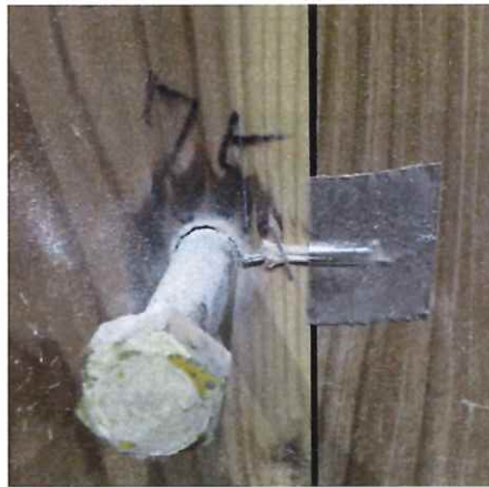
写真 1-71 仕様 25 の解体時 (CLT 表面) (複合・協会 M12 貫通ボルト+ナット)
