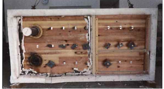
写真 3-58 加熱面・脱炉直後の解体時 (CLT 表面・胴縁)
