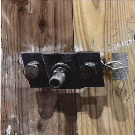
写真 2-73 仕様 35 の解体時 (CLT 表面) (直貼 コーチボルト M16+足改良-1+外壁 1)
