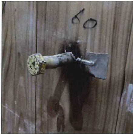
写真 1-39 仕様 10 の解体時 (CLT 表面) (単独 コーチボルト M12)
