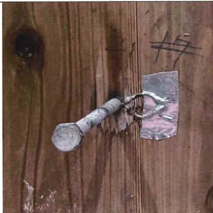
写真 2-21 仕様 9 の解体時 (CLT 表面) (胴縁 コーチボルト M9)
