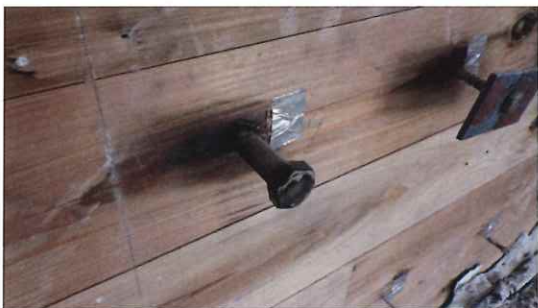
写真 3-15 仕様 5 の解体時 (CLT 表面) (直貼 コーチボルト M16/L125)
