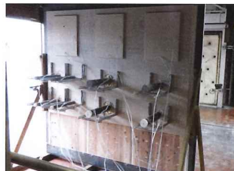
非加熱面側の施工状況 (全景)
