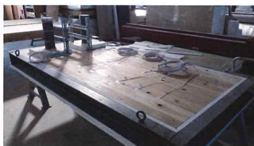
非加熱面側の施工状況 (全景)
