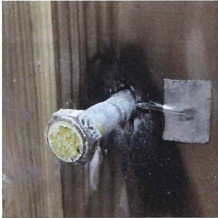
写真 1-69 仕様 24 の解体時 (CLT 表面) (複合・協会 コーチボルト M16)
