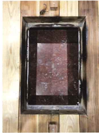
写真 1-4 仕様 2 の解体時（CLT 躯体）
