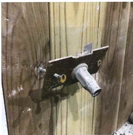
写真 1-61 仕様 20 の解体時 (CLT 表面) (複合・協会 パネリード(P6-110 II+)+足 B)
