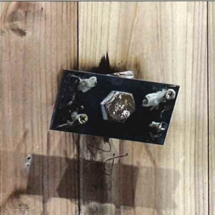
写真 2-51 仕様 24 の解体時 (CLT 表面) (直貼 コーチボルト M16+鉄板+GW カバー)
