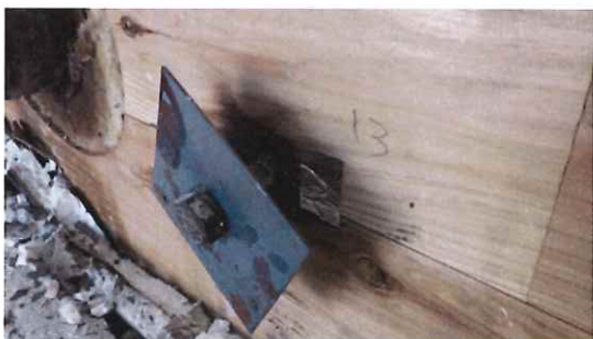
写真 3-23 仕様 9 の解体時 (CLT 表面) (直貼 コーチボルト M16+鉄板薄)
