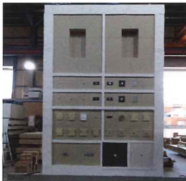
加熱面側の施工状況 (全景)
