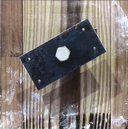
写真 2-55 仕様 26 の解体時 (CLT 表面) (直貼 コーチボルト M9+鉄板+RW カバー)
