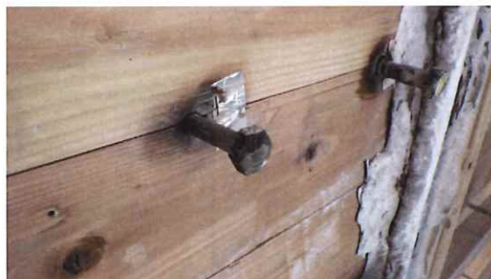
写真 3-11 仕様 3 の解体時 (CLT 表面) (直貼 コーチボルト M12/L125)
