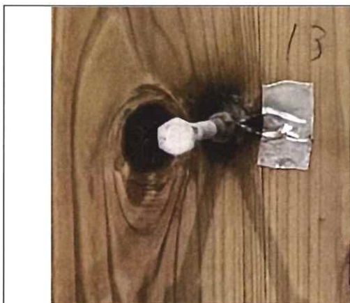
写真 2-5 仕様 1 の解体時 (CLT 表面) (胴縁+断熱材 コーチボルト M9)
