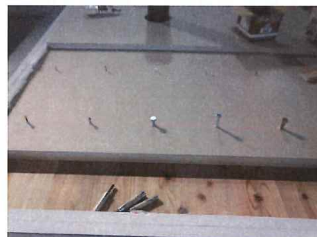
留め具の施工状況
