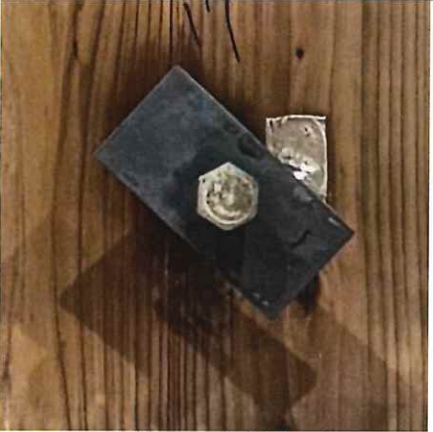
写真 2-15 仕様 6 の解体時 (CLT 表面) (胴縁+断熱材 コーチボルト M16+鉄板大)
