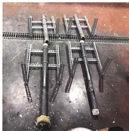
写真 1-8 配管の解体時（仕様 5～8）
