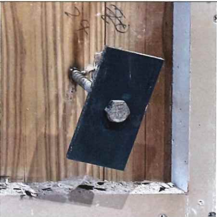
写真 2-27 仕様 12 の解体時 (CLT 表面) (胴縁 コーチボルト M9+鉄板)
