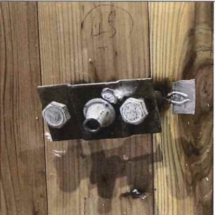
写真 2-69 仕様 33 の解体時 (CLT 表面) (直貼 コーチボルト M16+足改良-1)
