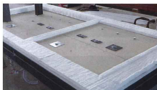
留め具の施工状況
