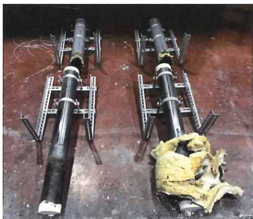
写真 1-7 配管の解体時（仕様 1～4）
