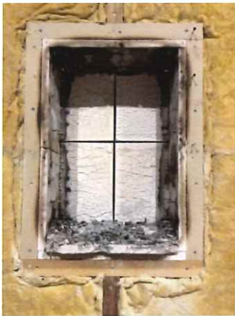
写真 1-3 仕様 2 の解体時 （不燃胴縁・木製胴縁）
