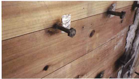
写真 3-9 仕様 2 の解体時 (CLT 表面) (直貼 コーチボルト M9/L125)
