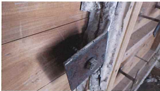
写真 3-21 仕様 8 の解体時 (CLT 表面) (直貼 コーチボルト M16+鉄板大)
