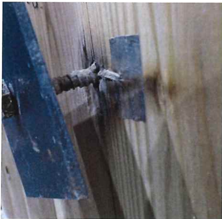
写真 1-53 仕様 16 の解体時 (CLT 表面) (複合 コーチボルト M9+鉄平板 t4.5)
