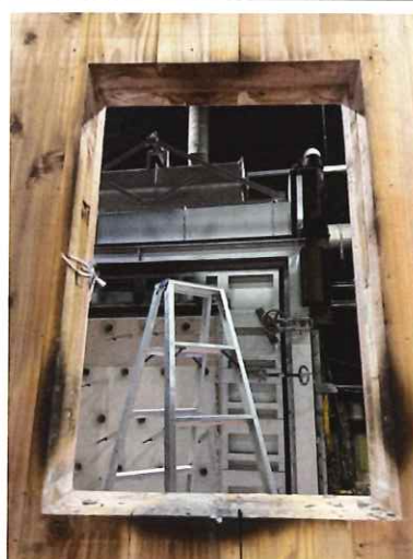
写真 2-4 仕様 2 の解体時（CLT 躯体）
