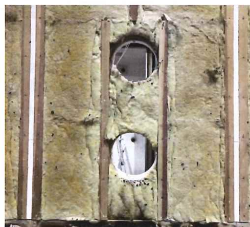
写真 1-10 仕様 3,4 の解体時（胴縁） （増張タイプ GB-F(V)21mm 厚×2 枚+RW）
