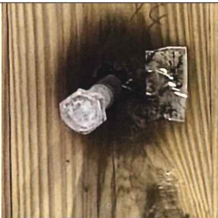
写真 2-7 仕様 2 の解体時 (CLT 表面) (胴縁+断熱材 コーチボルト M16/L100)
