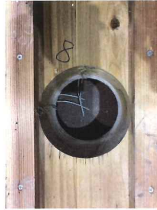
写真 1-20 貫通部・仕様 8 の解体時 (増張タイプ 鋼管 50GB-F(V)21mm 厚×2 枚+RW)
