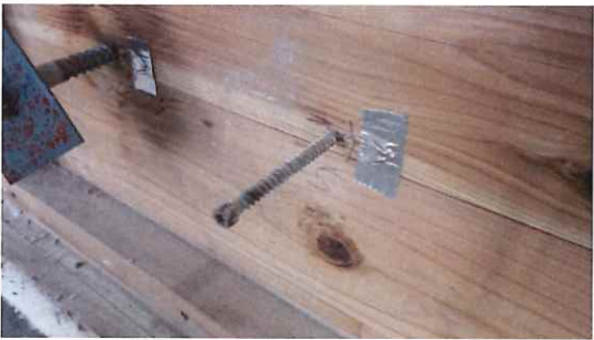
写真 3-47 仕様 21 の解体時 (CLT 表面) (胴縁 パネリード (PX8-110))
