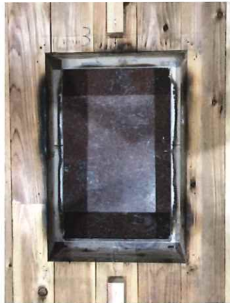
写真 1-6 仕様 3 の解体時（CLT 躯体）
