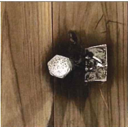
写真 2-9 仕様 3 の解体時 (CLT 表面) (胴縁+断熱材 コーチボルト M16/L125)
