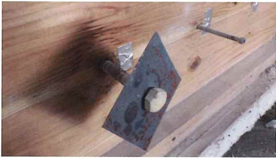
写真 3-45 仕様 20 の解体時 (CLT 表面) (胴縁 コーチボルト M16+鉄板薄)
