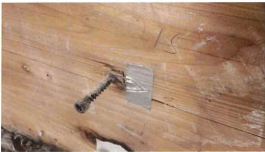
写真 3-27 仕様 11 の解体時 (CLT 表面) (直貼 パネリード (PX8-110))
