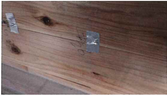
写真 3-49 仕様 22 の解体時 (CLT 表面) (胴縁 留め具なし)
