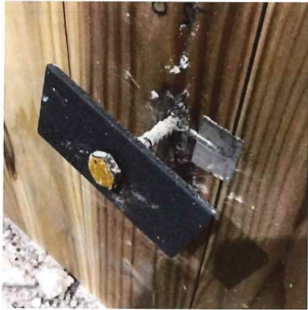
写真 1-51 仕様 15 の解体時 (CLT 表面) (複合 コーチボルト M9+鉄平板 t4.5)
