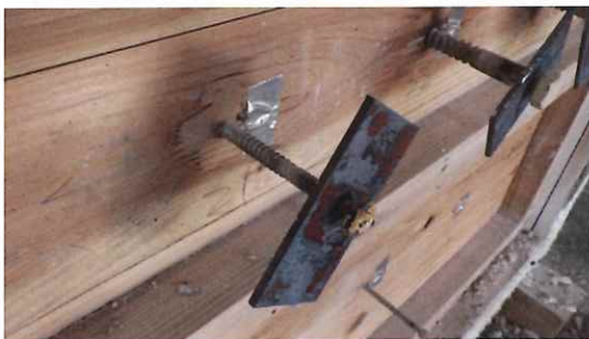
写真 3-39 仕様 17 の解体時 (CLT 表面) (胴縁 コーチボルト M9+鉄板)
