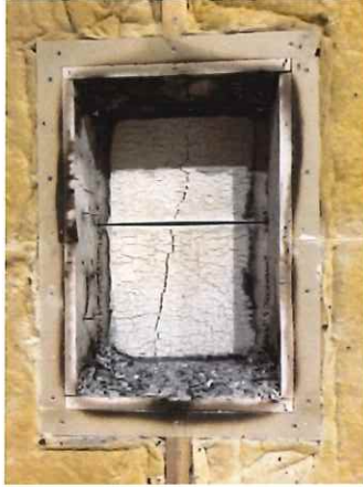
写真 1-1 仕様 1 の解体時（不燃胴縁）
