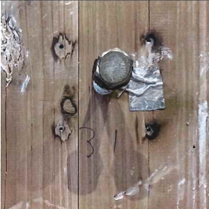
写真 2-41 仕様 19 の解体時 (CLT 表面) (直貼 コーチボルト M16+AES カバー)
