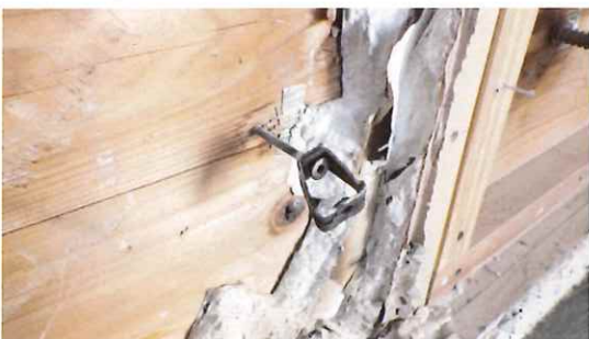
写真 3-29 仕様 12 の解体時 (CLT 表面) (直貼 サワラハンガー)
