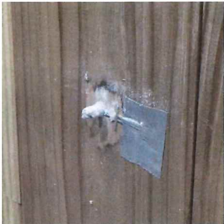
写真 1-33 仕様 7 の解体時 (CLT 表面) (単独 コーチボルト M6) ※解体時にコーチボルトの破断を確認
