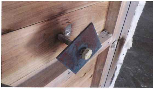
写真 3-43 仕様 19 の解体時 (CLT 表面) (胴縁 コーチボルト M16+鉄板大)
