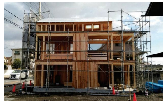
建て方完了時
