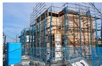
写真 2-6 本システム採用現場
