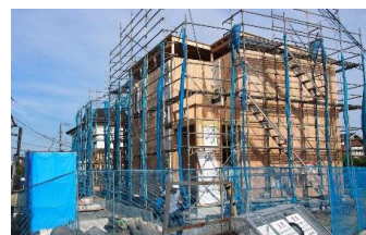
写真 2-6 本システム採用現場
