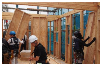
写真 2-5 パネル両側の柱配置ルール
