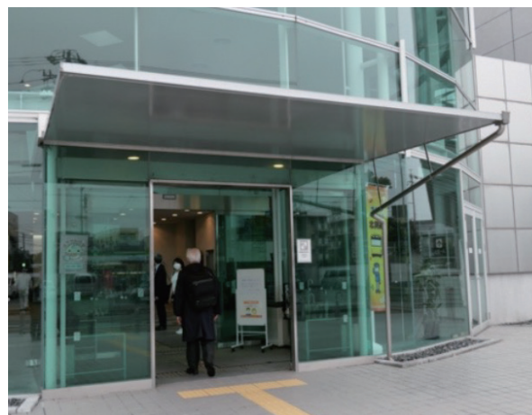
写真11 エントランス庇
