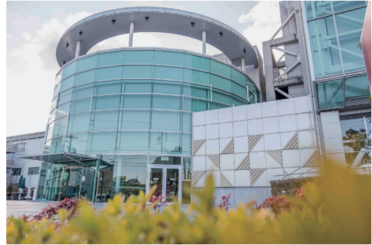
写真4 桑名市民会館外壁（木質化後）
