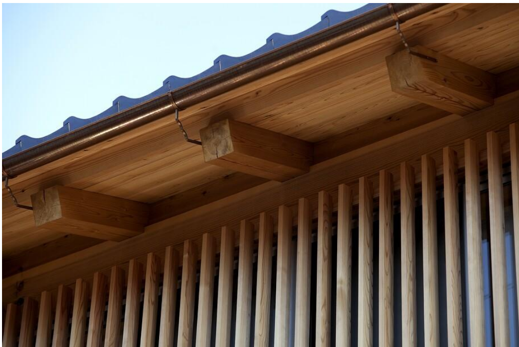
写真1 野地板を厚さ30mm以上、面戸板を厚さ45mm以上とした45分準耐火構造の木材あらわし軒裏
