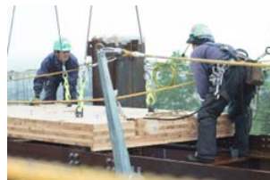
写真2 PW高森現場建方
