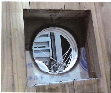
写真 1.3.2-134 貫通部・解体時 CLT 表面
