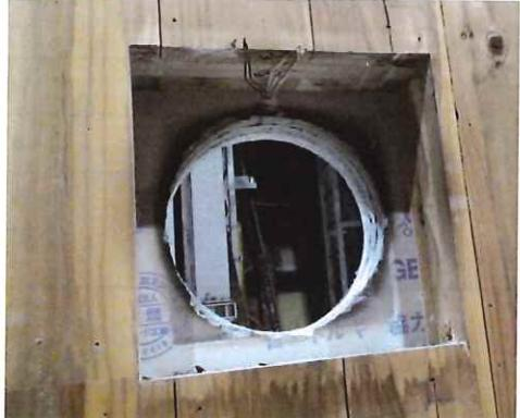
写真 1.3.2-135 貫通部・解体時 CLT 表面
