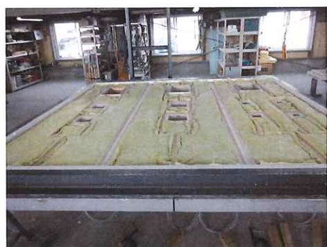
壁内（断熱材・胴縁）の施工状況
