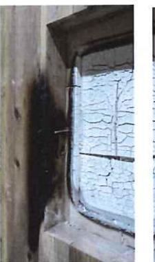
写真 1.3.2-130 開口部・解体時 CLT 表面
