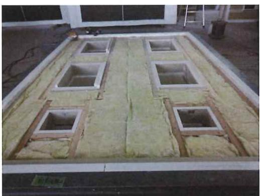
壁内（断熱材・胴縁）の施工状況
