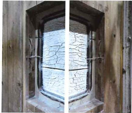
写真 1.3.2-132 開口部・解体時 CLT 表面
