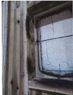
写真 1.3.2-185 加熱面・解体時 CLT 表面
