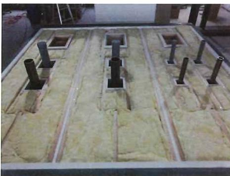
壁内（断熱材・胴縁）の施工状況
