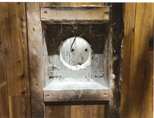
写真 1.3.2-70 加熱面・解体時胴縁表面
