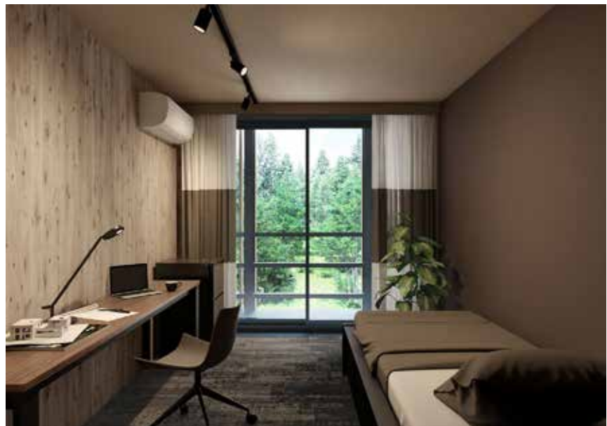
壁面のヒノキCLTをあらわしとした客室
