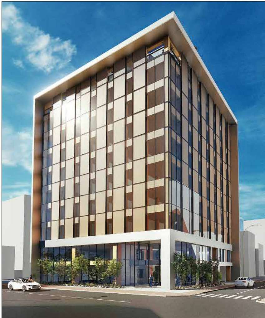
【最上階の coworking スペース】 壁、床を防火区画することで最上階の屋根を木造化しています。
