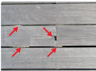
ウッドデッキ床板材に生じた欠損及び根太材の上に堆積した枯芝
