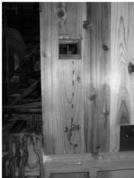
写真 1-4 引きボルト接合の例
