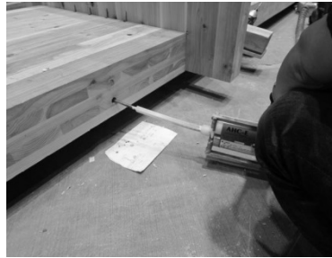
写真 1-2 GIR 接合の施工の様 子
