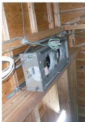
写真 天井カセット空調機の設置状況
