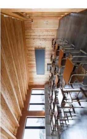
図 4.1.6 CLT ベネル工法を用いた郡山ヘーメイクカレッジ校舎
