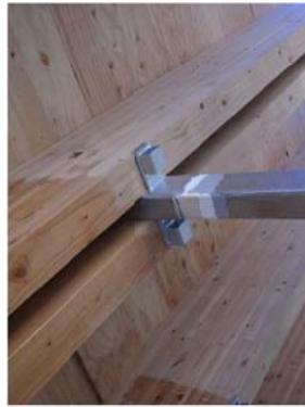
写真 鉄骨柱と木梁の接合部の施工状況
