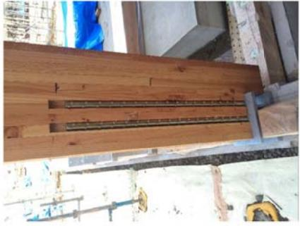
写真 高耐力の引抜金物の施工状況
