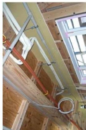
写真 天井カセット空調機の設置状況
