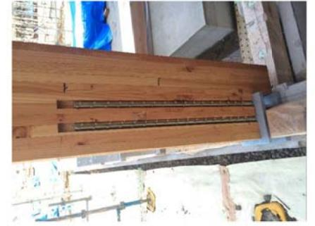
写真 高耐力の引抜金物の施工状況
