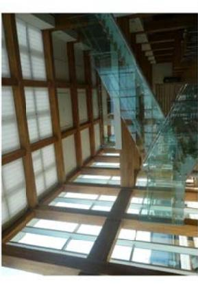
図 4.1.3 鋼材内蔵型耐火木造によるボラテック本社ビル
