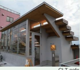
●CLTパネルを板としてうまく活かした例として、急勾配のCLTパネルによる屋根架構を用いた例がある。このような構造においては、CLTパネル間の接合部に生じる応力がそれほど大きくなりず、合理的な使い方である。
