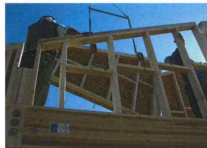
写真2-5-5 屋根パネル据付
