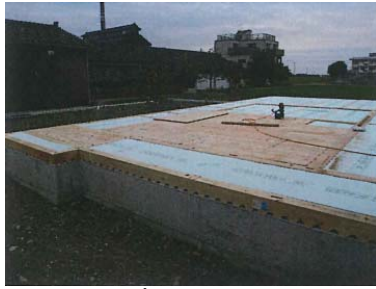
写真2-5-1 1階床張り工事床張り先行 作業用プラットフォーム
