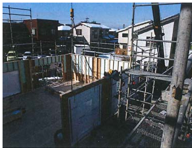
写真2-5-4 大型耐震断熱パネル建込み
