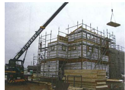
写真2-5-6 屋根パネル据付
