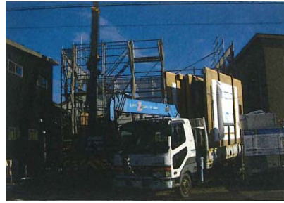
写真2-5-2 工場で作られた大型耐震断熱 パネル輸送
