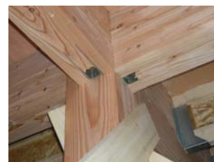
写真 2-2-1 専用梁受金物と納まり
