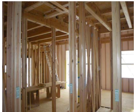
写真1 奈良県産材を使った構造躯体
