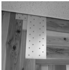
写真 1-1 鋼板添え板ビス接合の例 (せん断金物)
