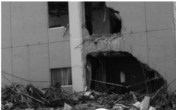
写真2-14 RC造の建築物(志津川)
