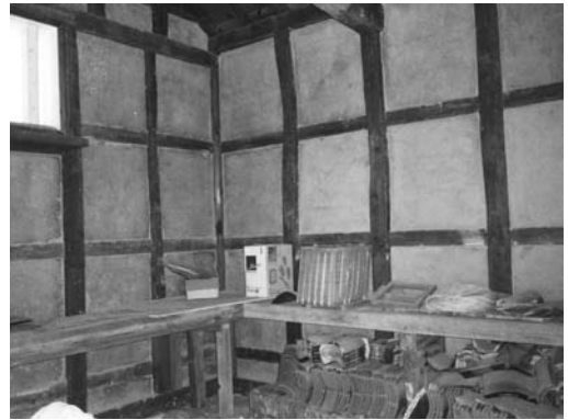
写真4-13 旧有壁本陣 土蔵内部
