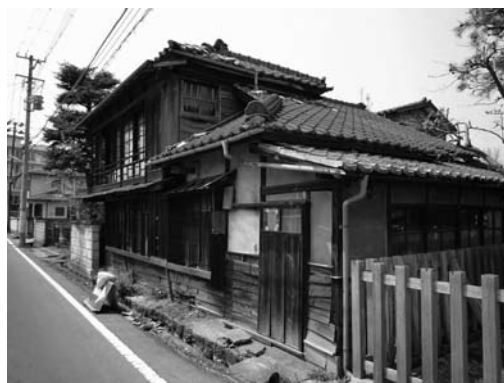
写真4-3 危険と判定された木造住宅(白石市)
