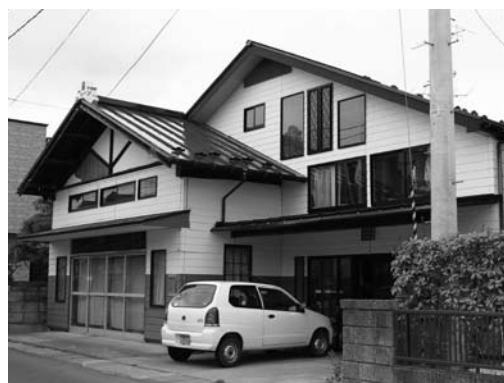
写真4-2 危険と判定された木造住宅(栗原市)
