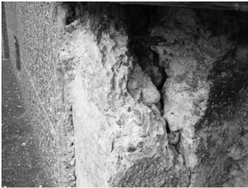
写真4-26 基礎の破損
