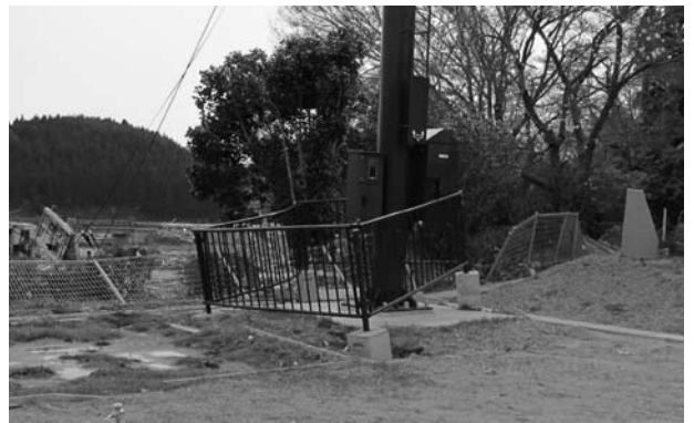
写真2-18 海側に傾いたフェンス(歌津 伊里前小学校)
