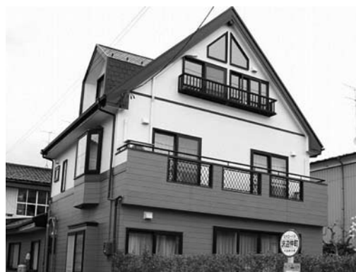
写真4-1 危険と判定された木造住宅(栗原市)
