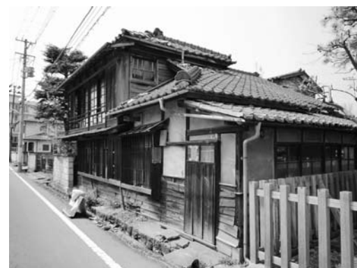
写真4-6 瓦の落下被害(福島市)
