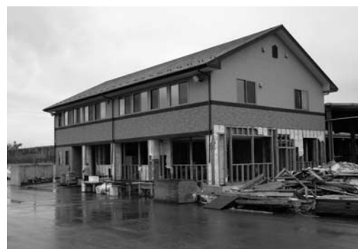
写真3-1 被災後の建物外観
