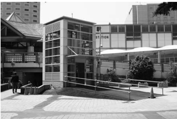
写真5-4 復旧後のエレベーター
