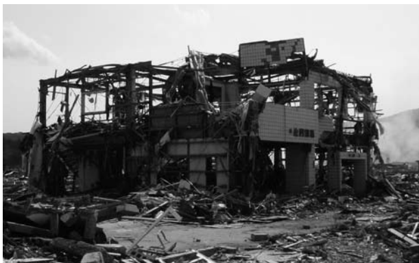
写真2-15 S造の建築物(志津川)
