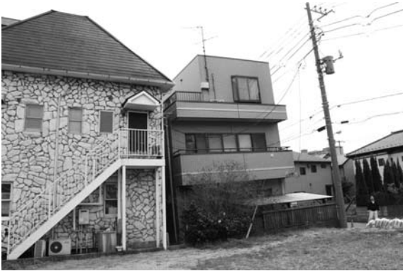
写真5-1 傾いた3階建て住宅(右側の建物)
