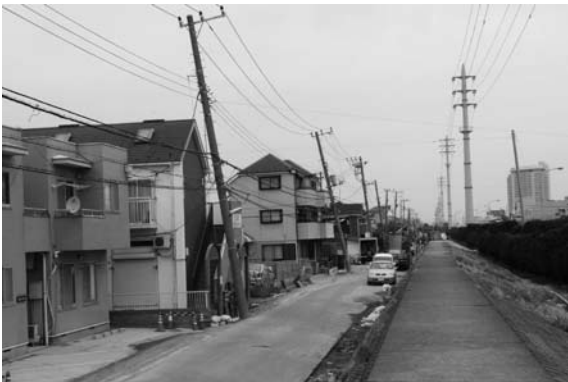
写真5-2 傾いた電信柱
