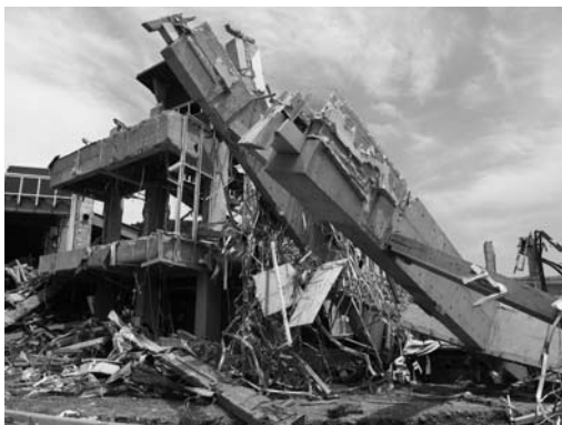
写真2-1 折れたRCの柱(海側)
