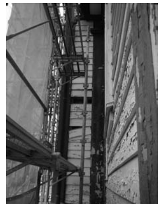
写真4-25 外壁の脱落
