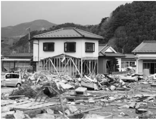
写真2-6 1階部分がピロティー化した住宅(海から約14km)
