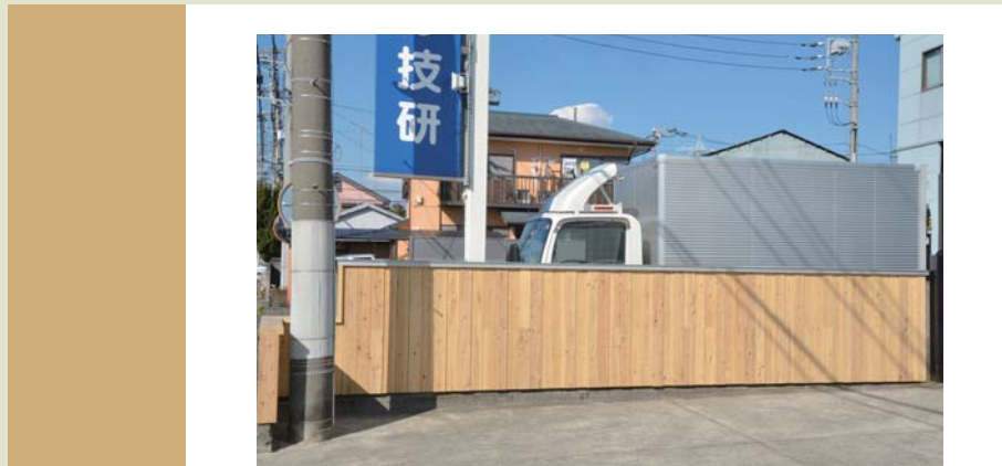
完成時（令和4年1月）
