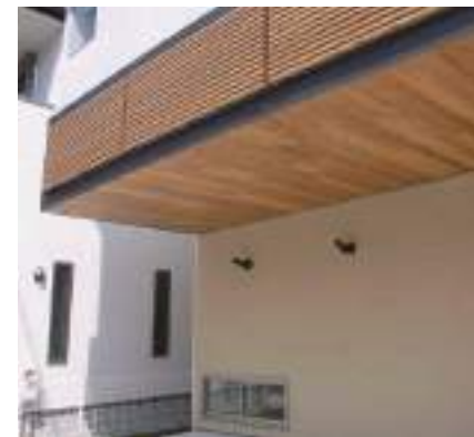
CLTによるはね出し部分
