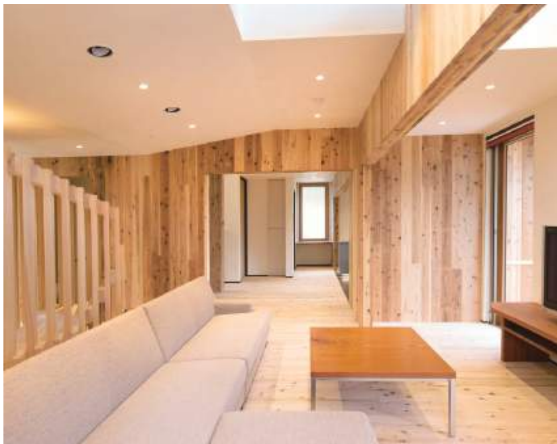
内壁にCLTを用い、これを現しとしている。垂れ壁の木口面が見える
