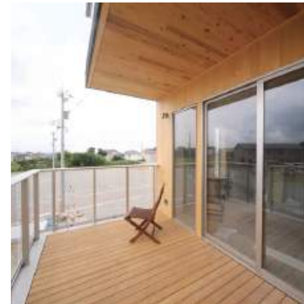
CLTはね出しによるテラス
