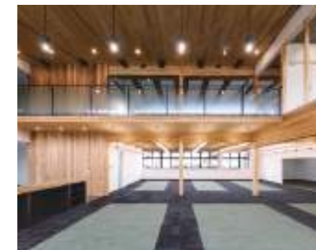
シンコール社屋 構造：CLTパネル工法 階数：2 延べ面積：755㎡
