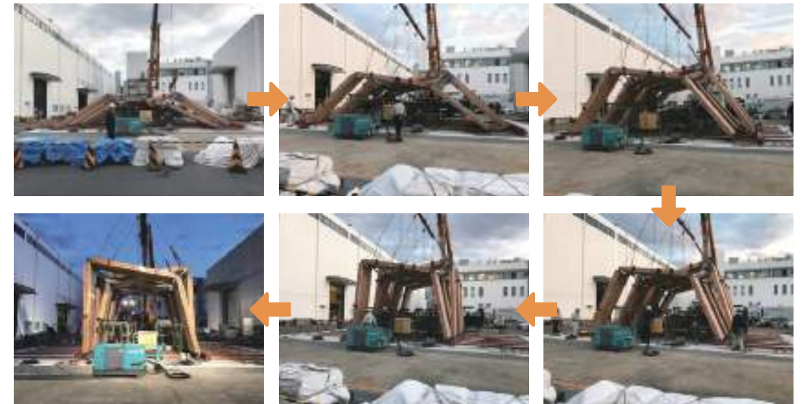
1/2モックアップによる施工実験
