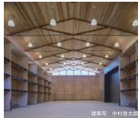
ミヨシ産業(倉庫棟) 構造：CLTパネル工法 階数：1 延べ面積：498㎡ ※詳細はP.26 建築写 中村啓太郎
