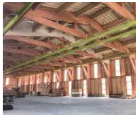
株中東 構造用集成材製造工場 構造：集成材等建築物+CLT(壁・梁) 階数：1 延べ面積：1,994㎡
