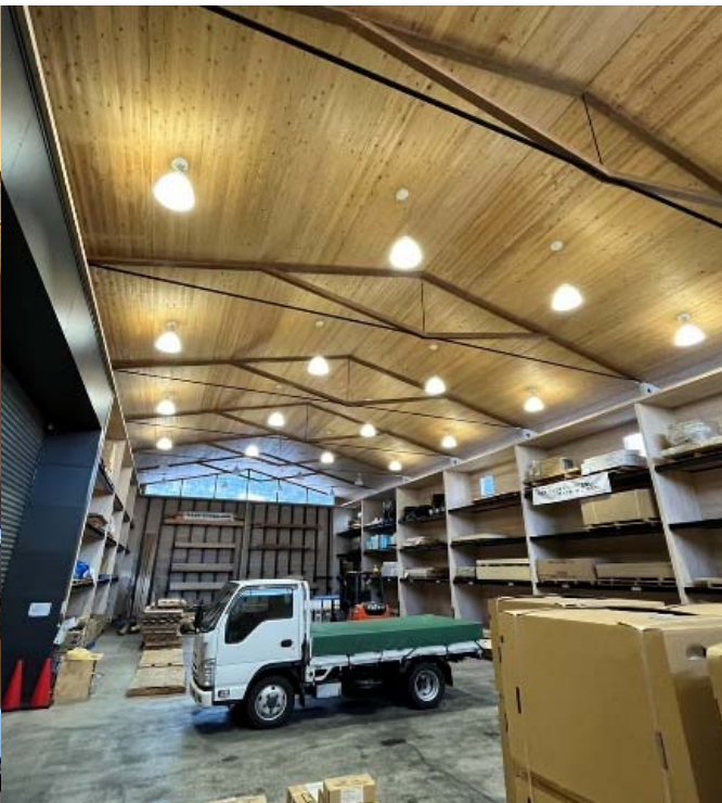
倉庫棟 内観写真
