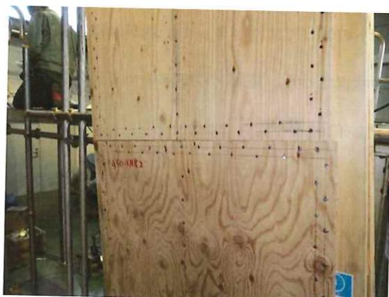
左側耐力壁の合板継ぎ目部
