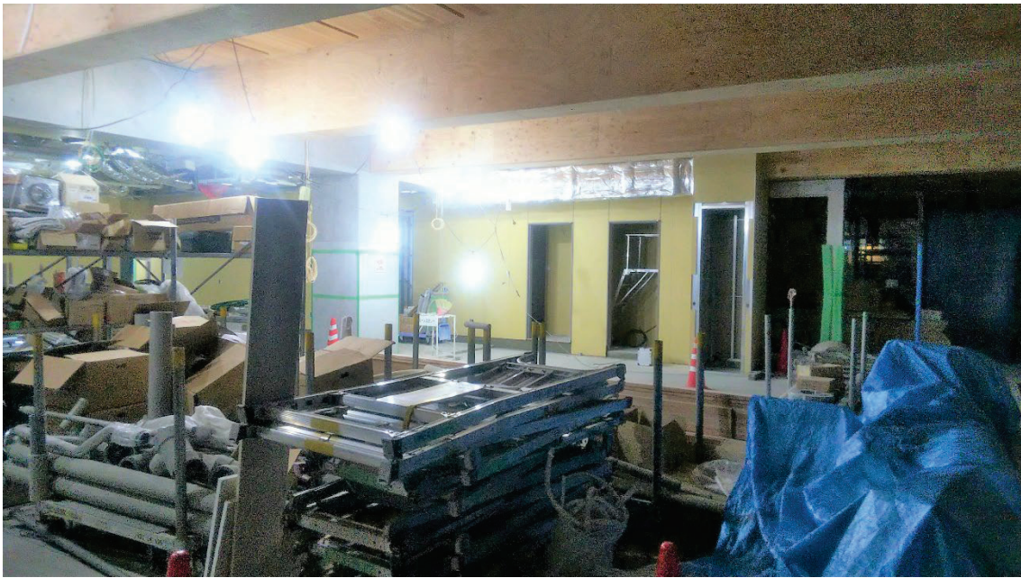
写真 8-5-3-1 測定現場内観：1階
