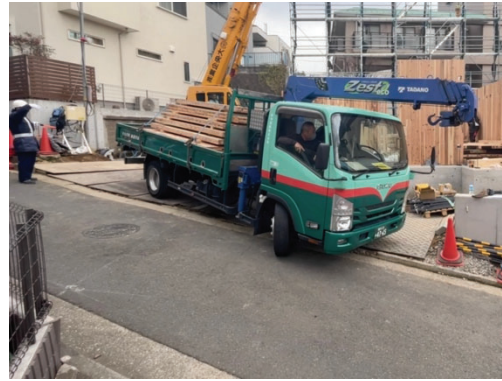
写真) 4t トラックによる敷地への搬入 横浜市西区
