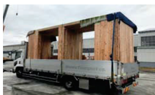
[4T車両でのユニット運搬状況]
