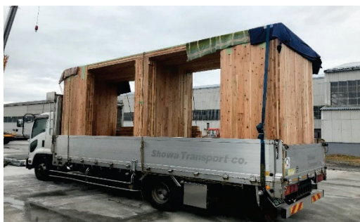
[4T 車両でのユニット運搬状況]
