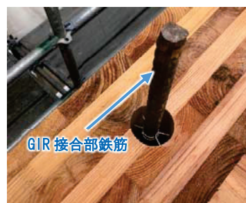
[壁頂部 GIR 接合部鉄筋]
