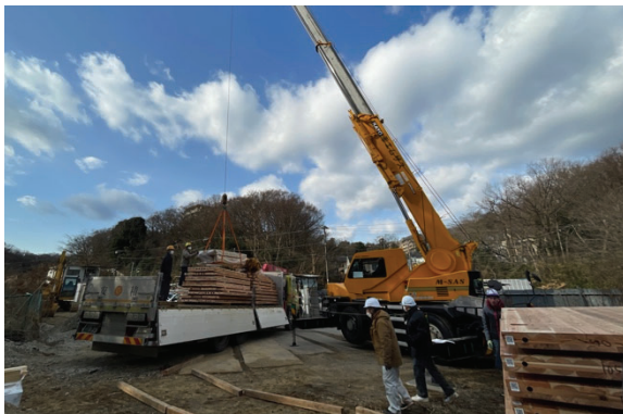
写真) 横浜市内の中継ヤード 横浜市保土ヶ谷区
