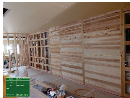
J パネル施工写真
