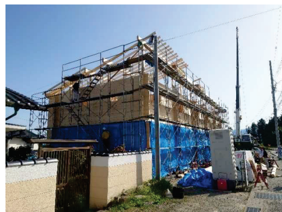
写真 4-7 CLT ログ壁の施工完了（2階まで）
