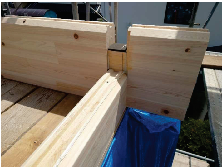
写真 4-3 ノッチ部の精度が高く隙間がない
