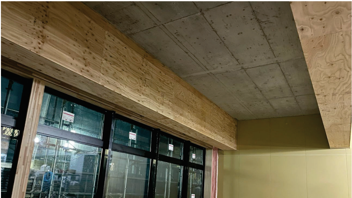
写真 8-5-3-4 RC 床施工状況 (測定経路(2)音源室床)
