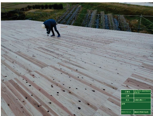
屋根 J パネル施工写真
