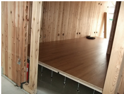
写-4 測定居室 1階の状況
