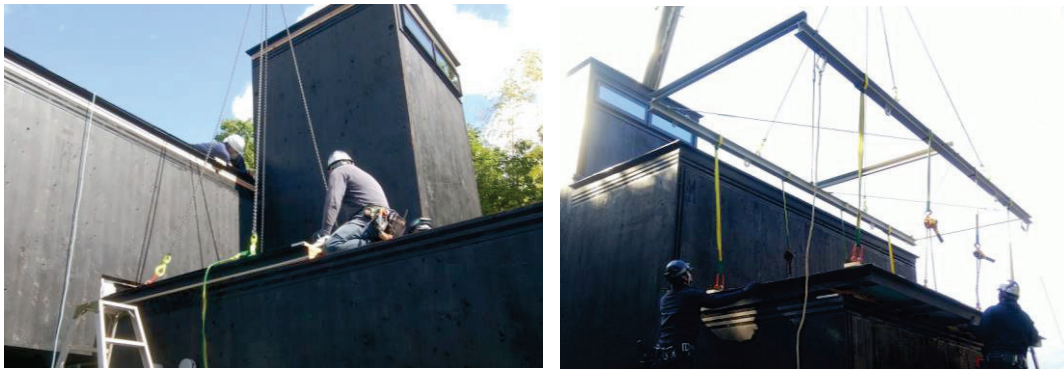
写真 4.4.2-1 屋根ユニット揚重方法の試行錯誤（左：1 屋根-2 ユニット分割案、右：1 屋根-1 ユニットとしてトラバーサーを使用した案）
