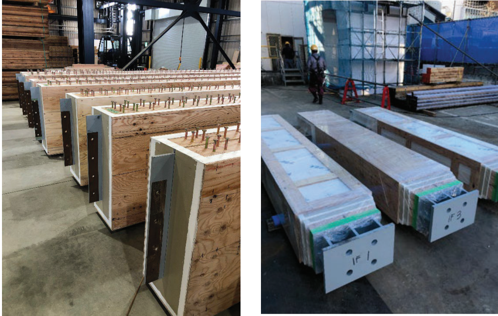
図 8-5-1-2. 耐火集成材 工場施工・養生状況
