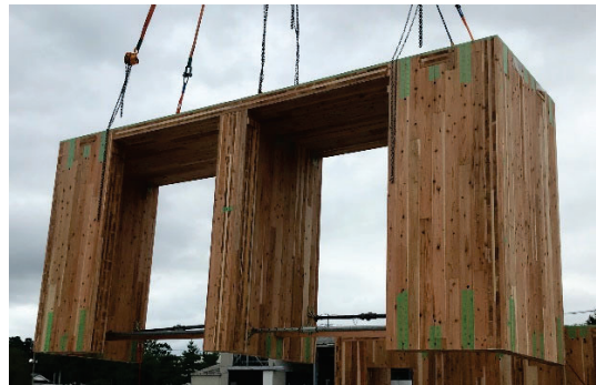
[ユニット①施工試験時写真]
