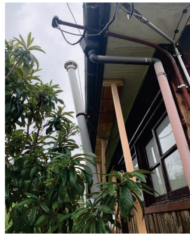
【南側】試験体設置状況
