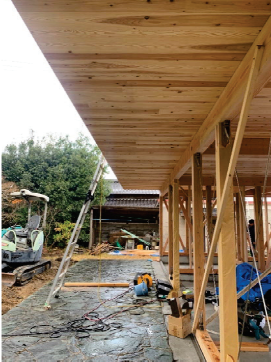
建て方完了時 施工写真
