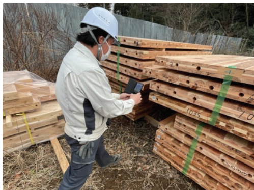
写真) 中継ヤードに運び込まれた CLT パネルの積載順を BIM モデルで確認している様子
