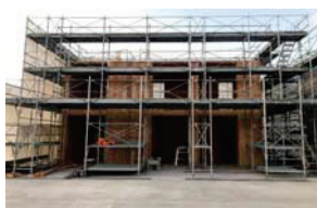
[遮音試験体施工状況]
