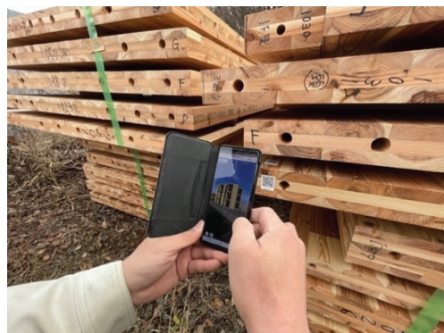
写真) 中継ヤードに運び込まれた CLT パネルの積載順を BIM モデルで確認している様子
