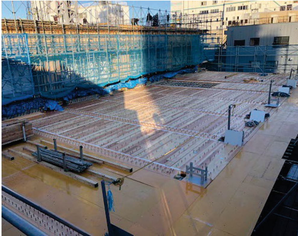
図 8-5-1-7CLT パネル養生状況・打設後の床版状況
