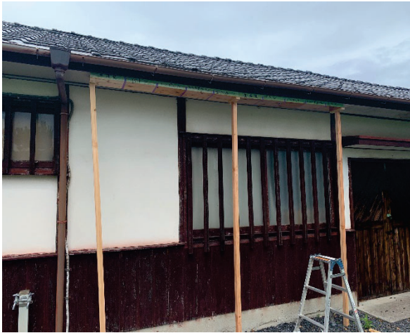
【西側】試験体設置状況
