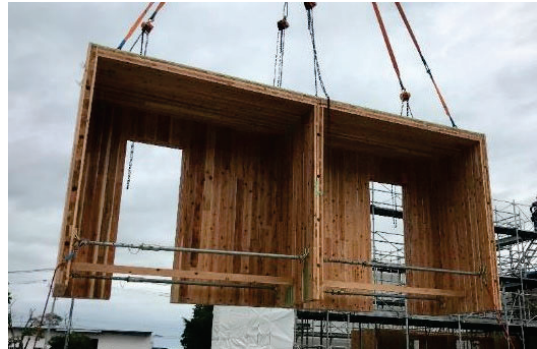
[ユニット②施工試験時写真]
