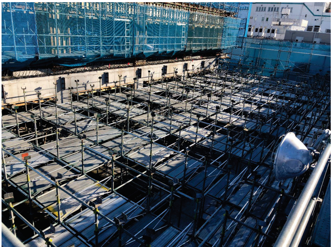
図 8-5-1-5 CLT パネル支保工設置状況
