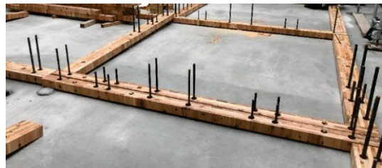
[ユニット下部施工試験時写真]
