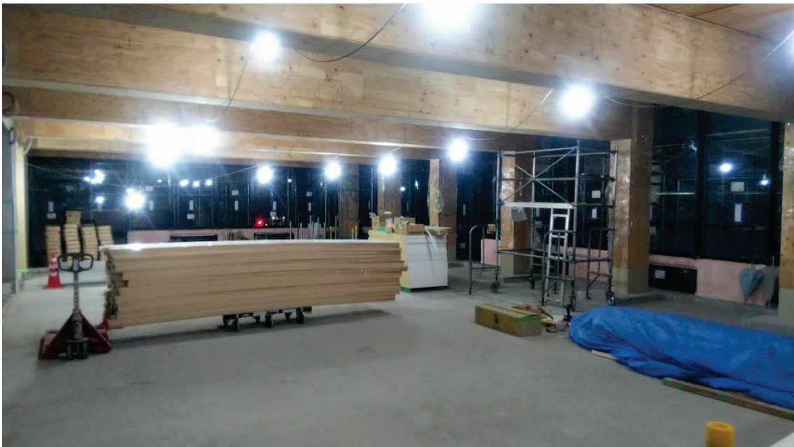
写真 8-5-3-2 測定現場内観：2階
