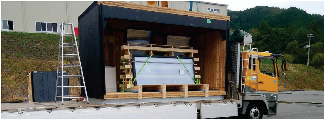
写真 4.3-1 ユニット内部に格納したガラス障子の運搬の様子
