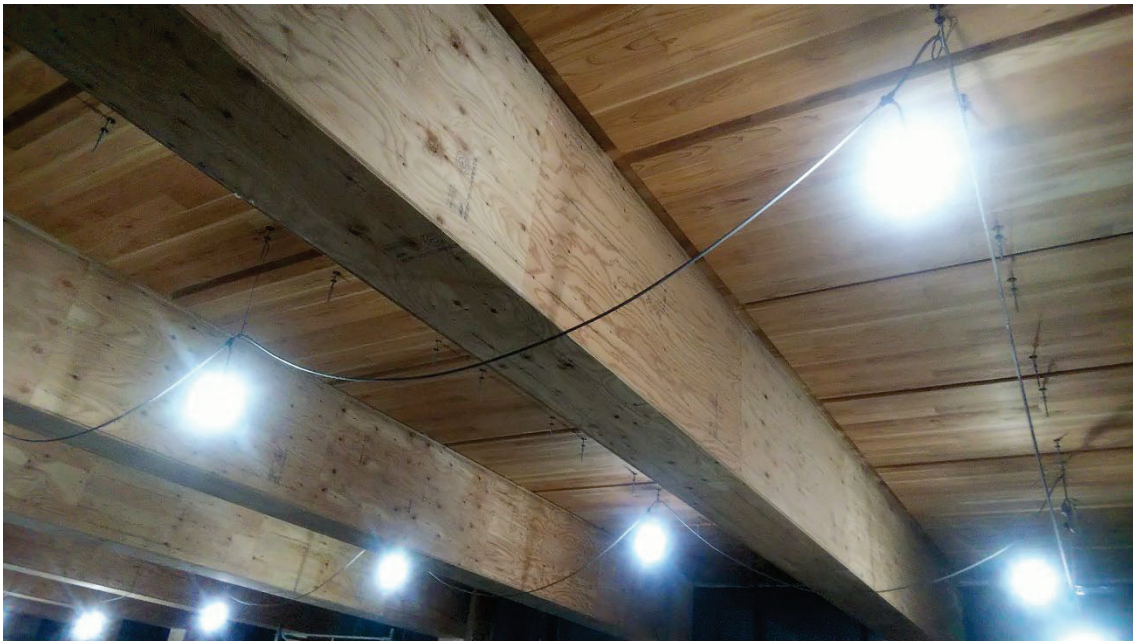
写真 8-5-3-3 CLT 床施工状況 (測定経路(1),(3)~(5)音源室床)
