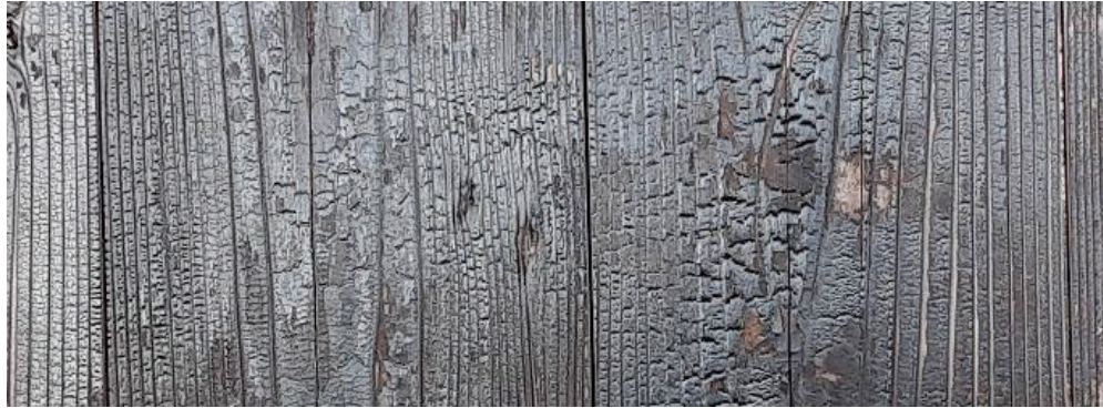
写真 3.4.3-1 焼杉処理無塗装の部分拡大（2022年1月5日撮影）
