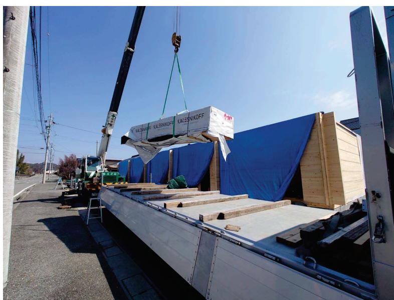
写真 4-1 資材搬入状況
