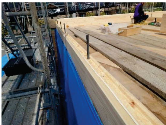
写真 4-5 ダボ施工時の様子
