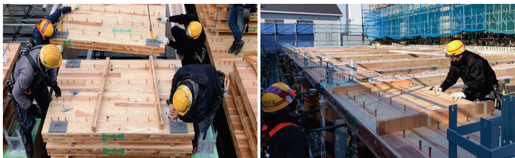
図 8-5-1-6CLT パネル支保工設置状況
