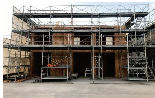
[遮音試験体施工状況]
