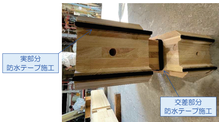
写真 3-1 防水テープ施工
