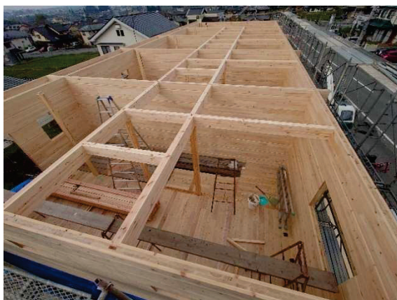
写真 4-6 2階床組み
