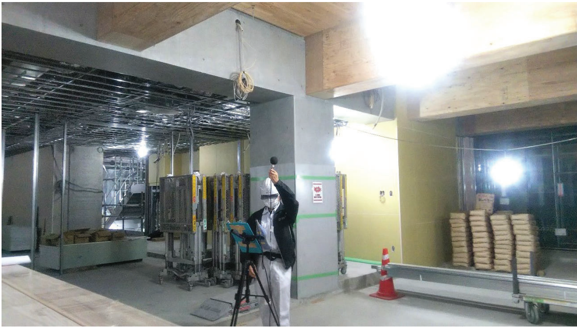
写真 8-5-3-7 受信室測定状況
