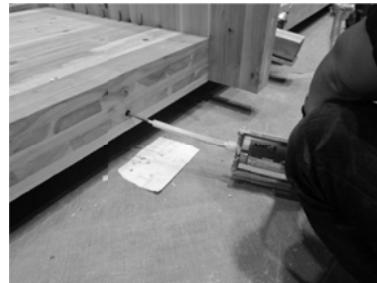
写真 1-2 GIR 接合の施工の様子
